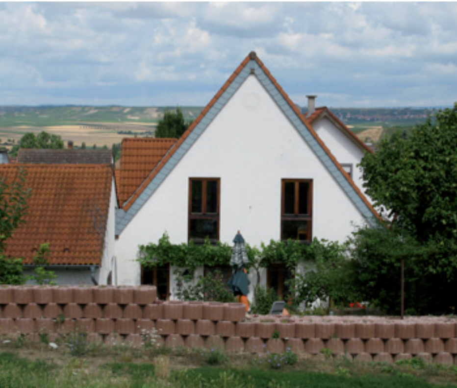
Abb. 34: Mauer aus Flora-Wall-Steinen zum Schutz vor Außengebietswasser
