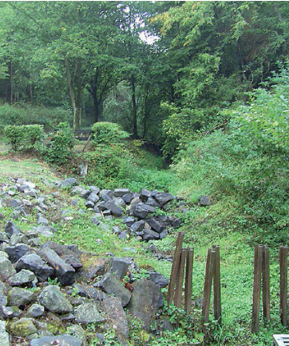
Abb. 33: Minderung der Fließgeschwindigkeit am Hammersteiner Bach durch Steinschüttungen und Absperrungen
