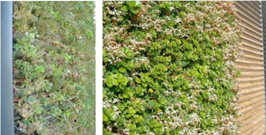
System *Fa. Limeparts*. Gut erkennbar auf den Abbildungen ist die Schrägstellung der Kassetten. Diese wurden mit *Sedumarten* bepflanzt und können einzeln ausgetauscht werden.
