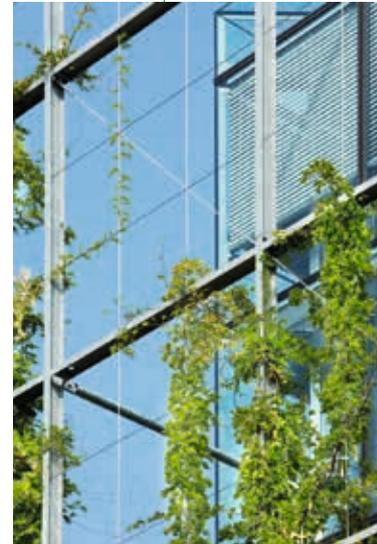
Flächige Konstruktion mit Stahlrahmen und Seilen als Kletterhilfe für Glycerie (*Wisteria sinensis*) und Knöterich (*Fallopia aubertii*)
