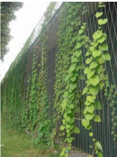
Stahldrahtnetz als flächige Kletterhilfe
